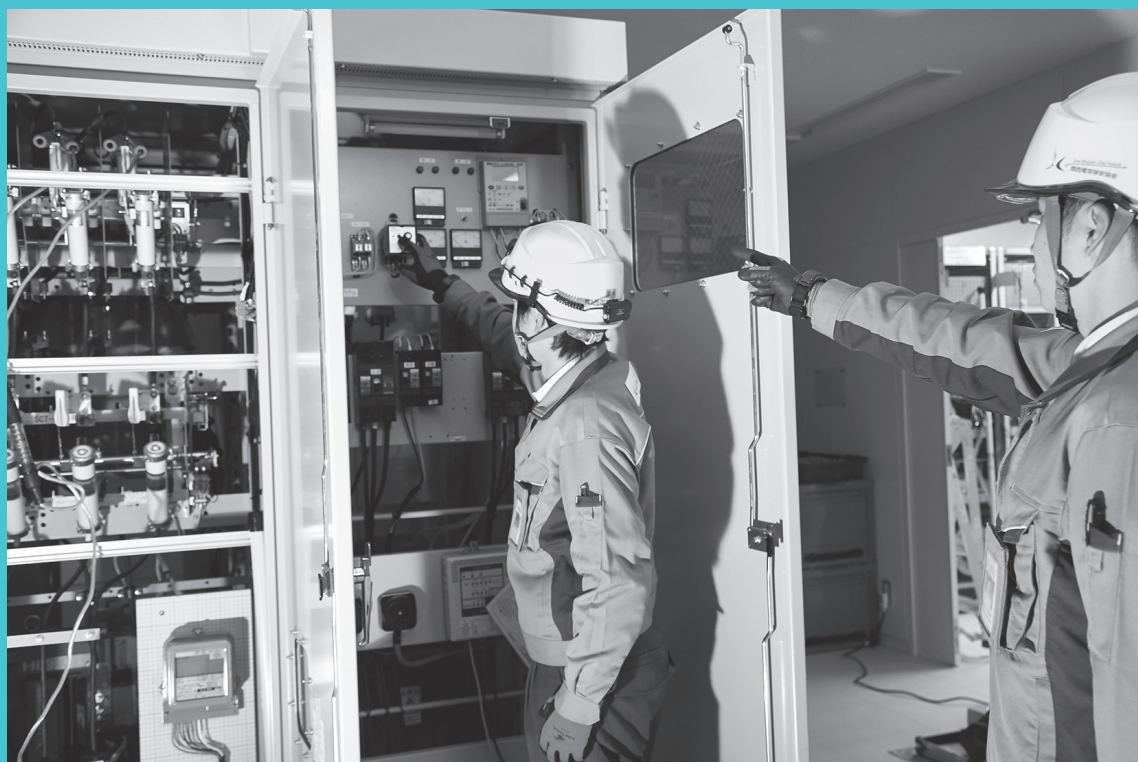
「人財開発センター」にて年次点検の研修を行っている様子 写真提供:一般財団法人関西電気保安協会
